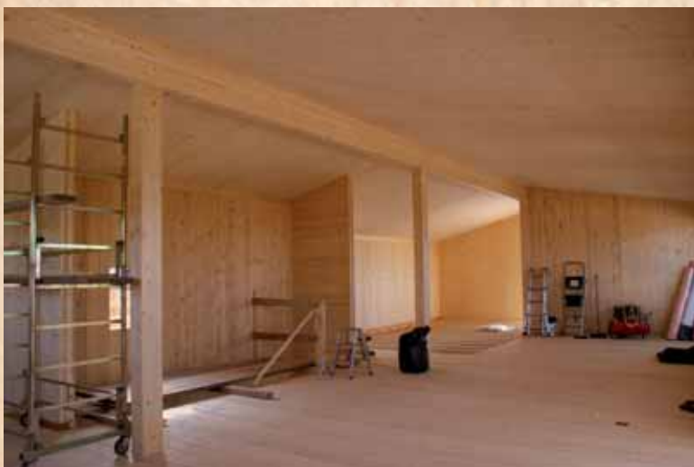
All'interno sono in legno sia le strutture portanti che i rivestimenti
