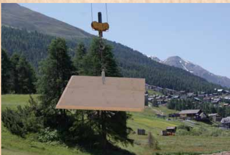
Sopra la posa di un elemento della struttura.
